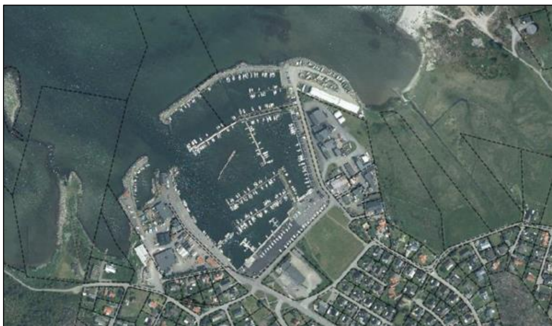
Figur 6. Flygfoto över Bua hamn från 2019. Källa: Varbergs kommun.
